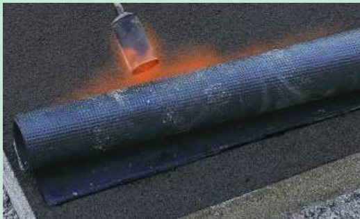
Saldatura guaina bituminosa su primer
