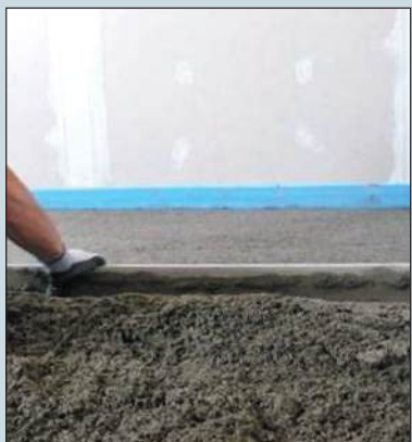
Sistema G DRY FAST Posa massetto cementizio
