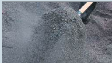
Sistemi G DRY SYSTEM e G DRY FAST Posa sottofondo a secco G MIX GRANULAR
